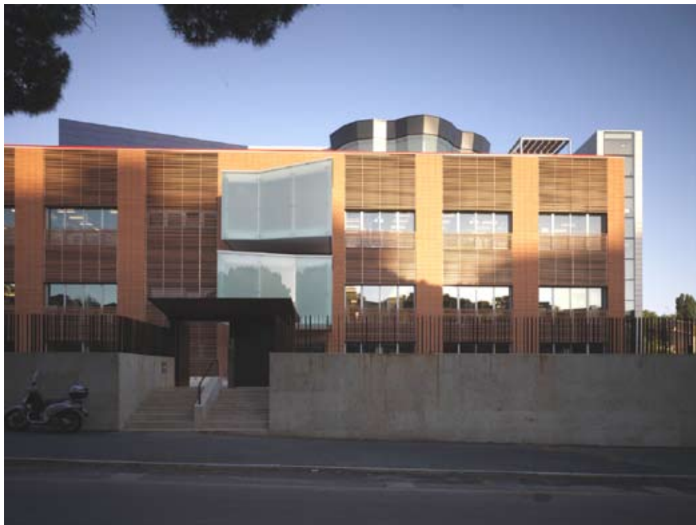
Ingresso nord del Centro. La facciata ventilata in laterizio è allineata lungo la strada.
