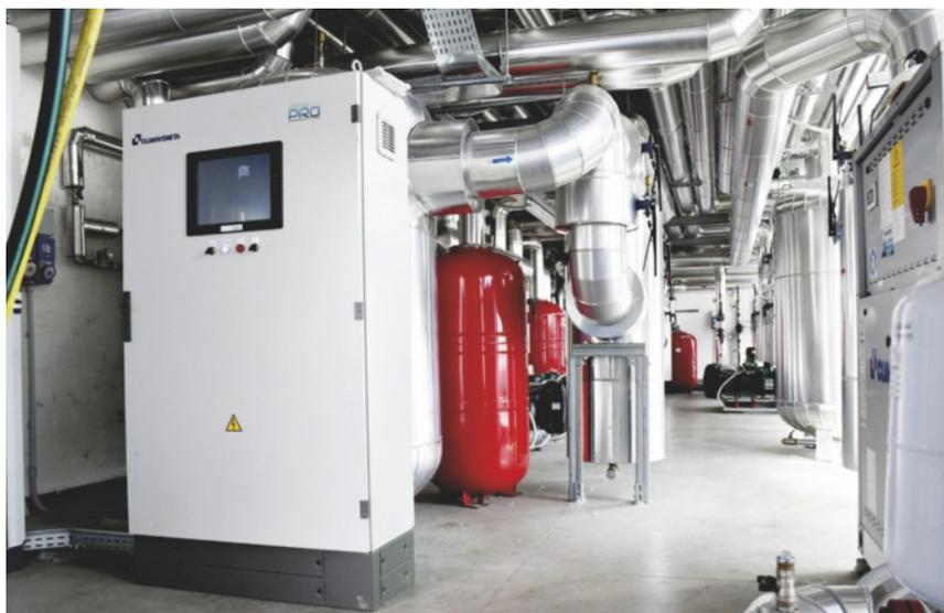
Le caratteristiche dei generatori e la loro logica di funzionamento sono state orientate dalla tipologia della rete di distribuzione e dall'esigenza di produrre gratuitamente l'acqua calda nel periodo estivo (General Planning).
