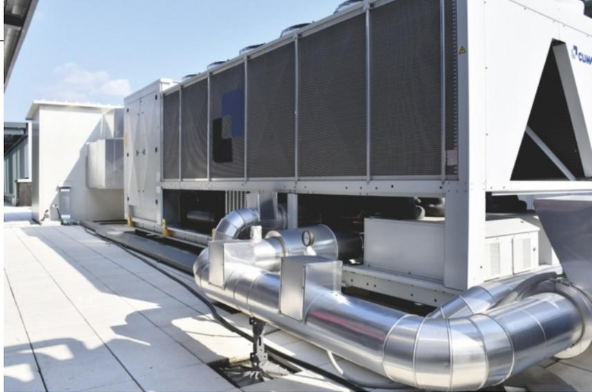
La centrale termofrigorifera situata sulla copertura è composta da pompe di calore di tipo polivalente e reversibile, che si suddividono la produzione dei fluidi termovettori a seconda delle condizioni stagionali (General Planning).
