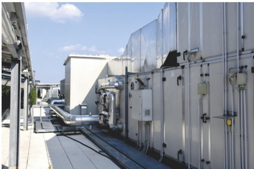
Attestato su 2 UTA a tutt'aria esterna dedicate alle zone est e ovest dell'edificio, l'impianto ad aria primaria garantisce una qualità dell'aria almeno al livello IDA 2 (General Planning).
